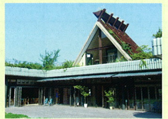
暑くても屋上緑化で中は涼しい
