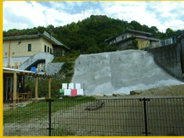
施設下の道路から見える整備箇所
