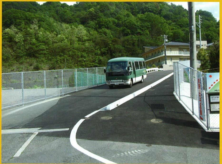
完成後の導入路。歩行者通路が確保されています。
