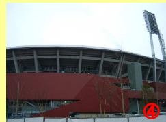
④新球場(工事中)
