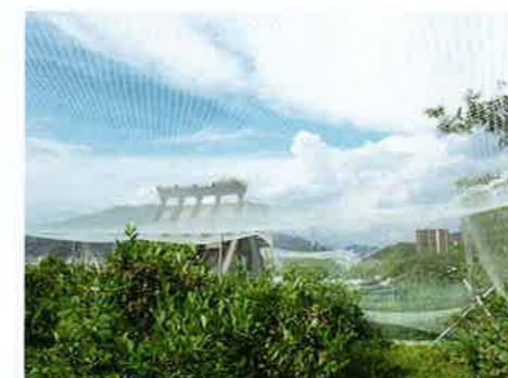
・森の工房AMAの屋上 (防鳥ネットをはっています)
