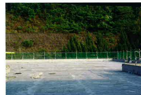
建設中の屋上、この上に土を盛っていきます
