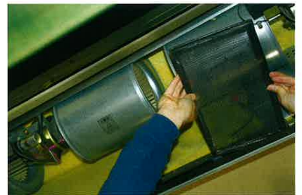
エアコンフィルター取替え中
