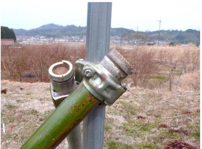
③ 支柱に使ったのは里山の竹の伐採で出た竹で、単管パイプ用のクランプの径にちょうど合う竹を選
