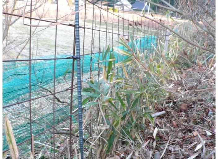
③ 里山の防獣柵の補修を続ける。棒杭が腐ってグラグラしている柵なので鉄筋を打ち込みワイヤーメッシュを結束バンドでくくる。
