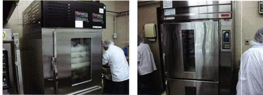
平成26(2014)年の12月13日に 取り付け工事を行いました
