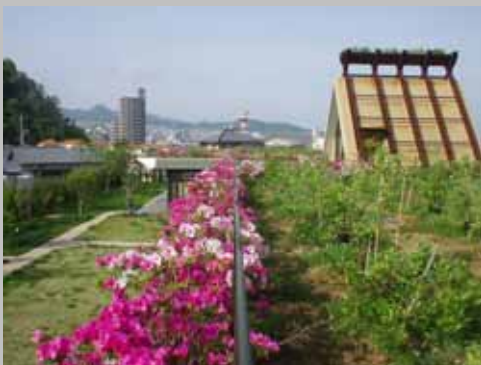
1 - 5 月。屋上周圍の 800 本のヒトツツが満開。屋上緑化で、夏の室温は締め切っても 35 度以上は上がらない。冬の保温も優れている。
